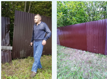
Алексей Геннадьевич Б. (Московская обл.) 28 000 руб. ремонт забора вокруг дома.
